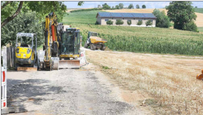
Bauarbeiten zur Regenwasserableitung
