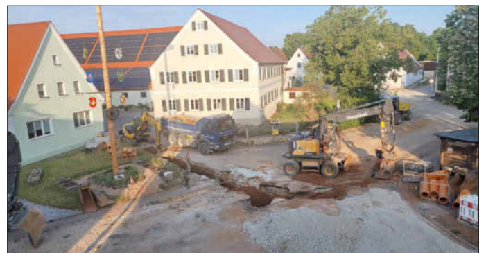
Kanalarbeiten am Dorfplatz
