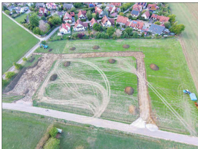
Beim Drohnenüberflug über das neue Baugebiet „Am Schießespan“, kann man das gesamte Ausmaß dieser zukunftsweisenden Baumaßnahme erkennen
