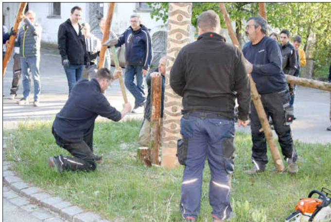
Abschließend wird der Baum in der Hülse ausgerichtet und fixiert.
